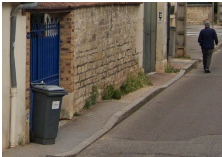
(Rue Le Nôtre à Dijon, un trottoir à reconfigurer !)
